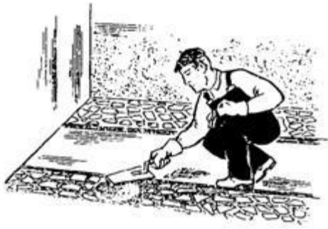
Рис. 61. Выравнивание мозаичной смеси в полосах-захватках растворомной лопаткой
