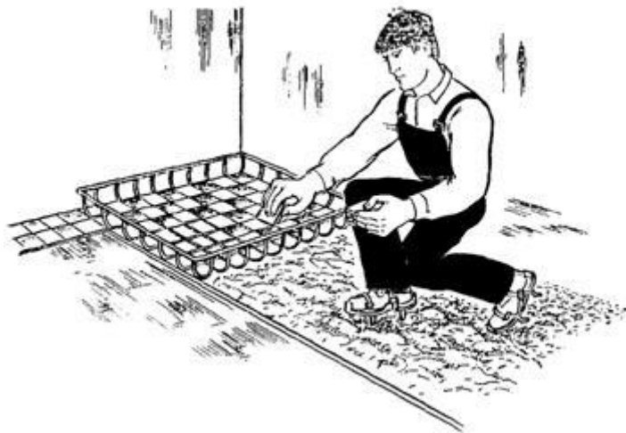
Рис. 34. Настилка пола с помощью клеточного шаблона
