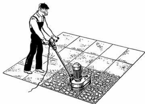
Рис. 71. Шлифовка мозаичного покрытия
