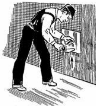
Рис. 90. Нанесение штукатурного раствора на стальную сетку
