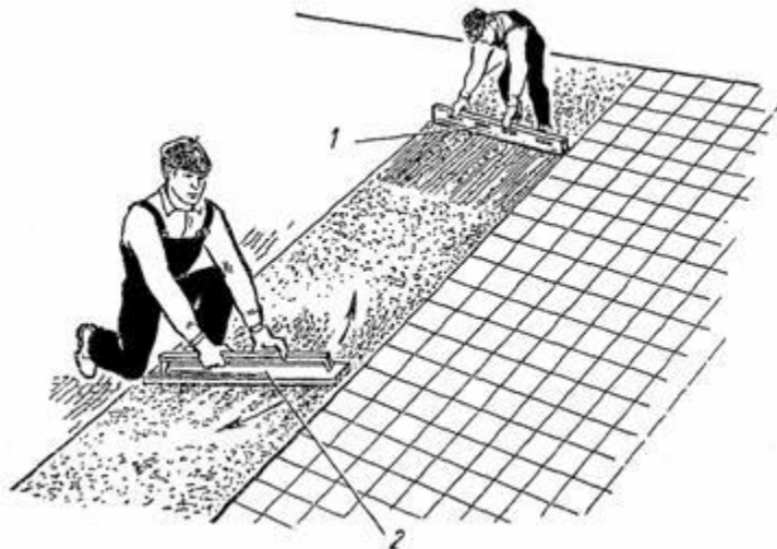
Рис. 37. Укладка растворной прослойки: 1 - правило, 2 - полутерок
