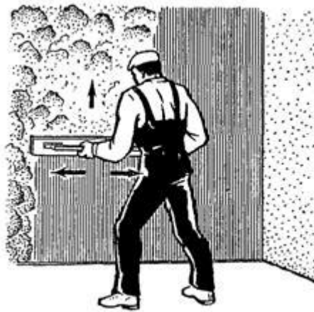
Рис. 94. Разравнивание раствора полутерком
