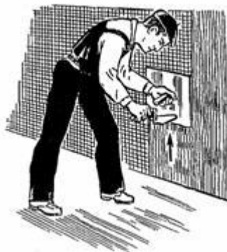
Рис. 90. Нанесение штукатурного раствора на стальную сетку
