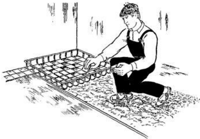
Рис. 34. Настилка пола с помощью клеточного шаблона
