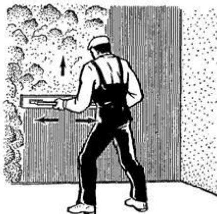
Рис. 94. Разравнивание раствора полутерком
