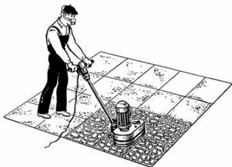
Рис. 71. Шлифовка мозаичного покрытия
