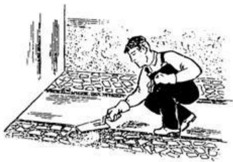
Рис. 61. Выравнивание мозаичной смеси в полосах-захватках растворомной лопаткой
