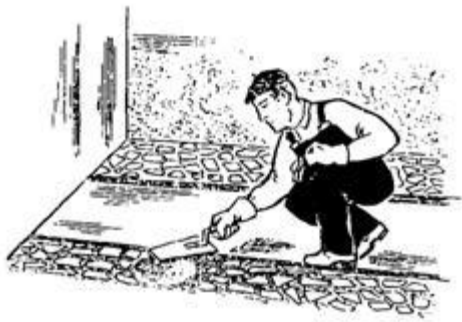
Рис. 61. Выравнивание мозаичной смеси в полосах-захватках растворомной лопаткой
