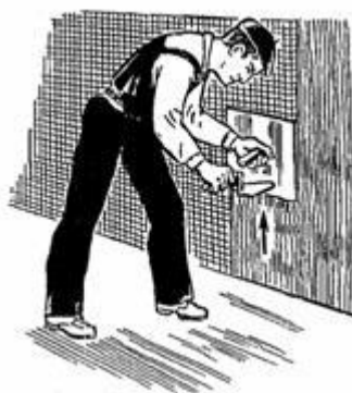
Рис. 90. Нанесение штукатурного раствора на стальную сетку
