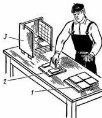
Рис. 1. Организация рабочего места при сортировке плиток:
